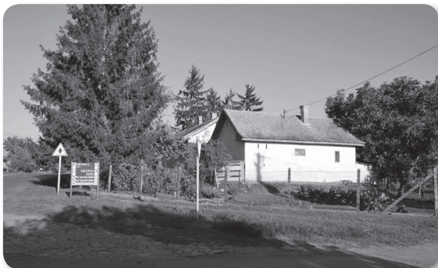
A garai állomás északi őrháza
